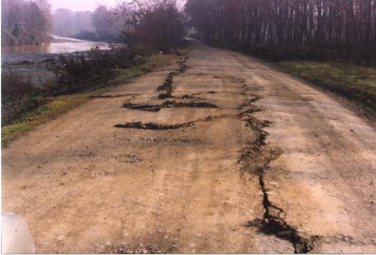
(Kaynak: http://www.koeri.boun.edu.tr/jeofizik/duzce21.jpg ; Fotoğraf Erdal HERECE, Yolun 45 cm sağ-yanal atımı)
