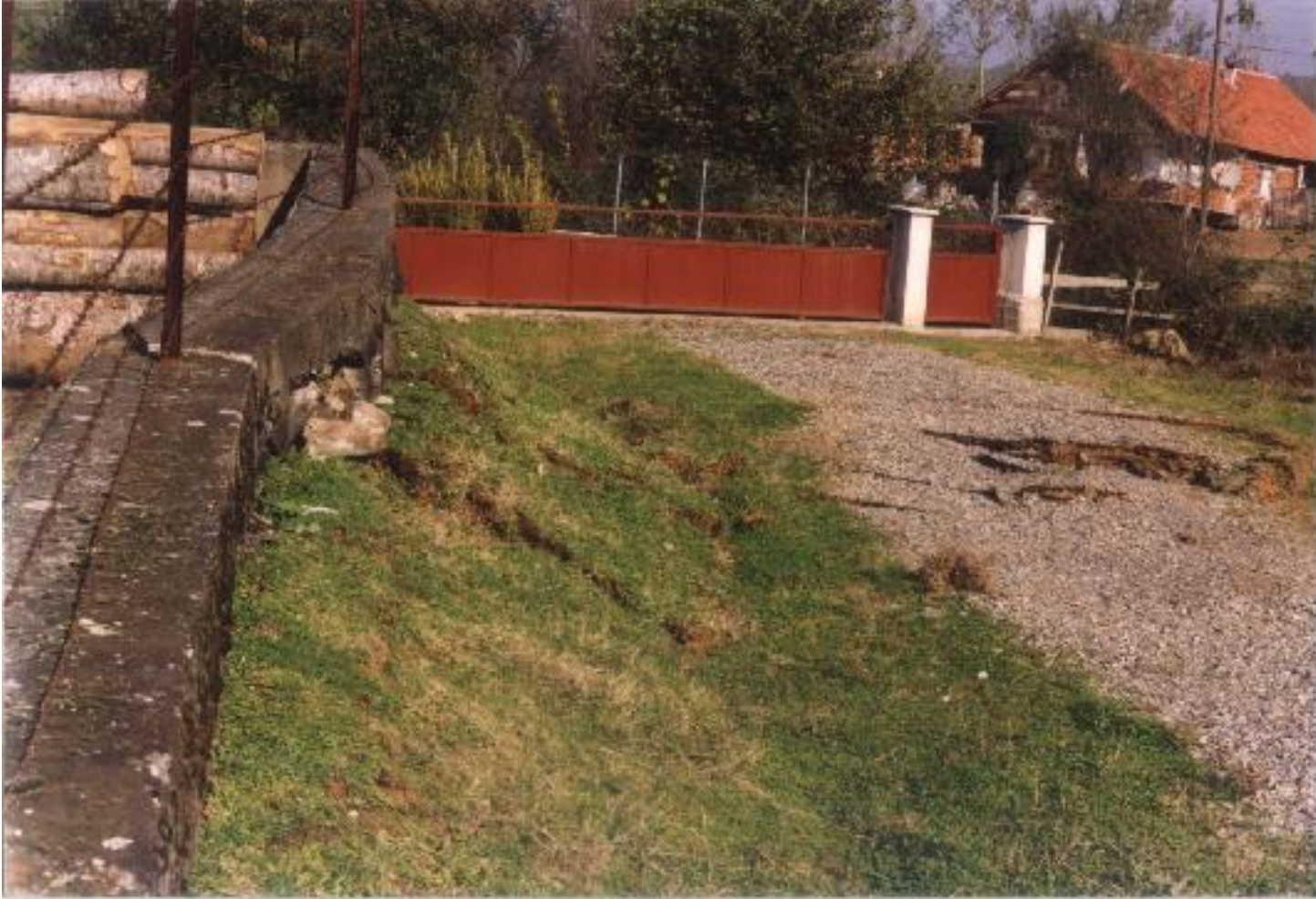
6. Şekil 5 de gösterilen güney kolun doğuya doğru sonuçlanmakta olduğu yerde görülen 70 cm'lik sağ-yanal atım. Fotoğraf: Erdal HERECE
