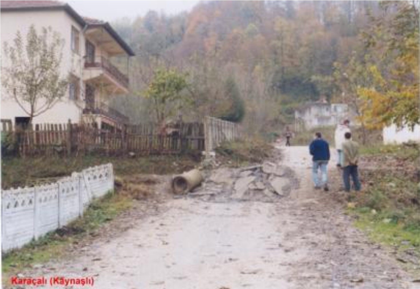
Karaçalı (Kaynaşlı) Şekil 6i. 2 m sağ yanal olarak ötelenmiş bir mahalle yolu ve bahçe çiti (Karaçalı Mah.-Kaynaşlı).
